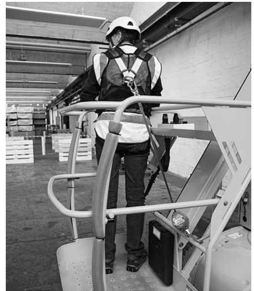
Bild 1: Auf Ausleger-Hubarbeitsbühnen besteht erhöhte Absturzgefahr. Für jede Person auf der Bühne braucht es ein Rückhaltesystem (Auffanggurt und einstellbares Verbindungsmittel von max. 1,8 m Länge) und einen Schutzhelm mit Kinnriemen.
